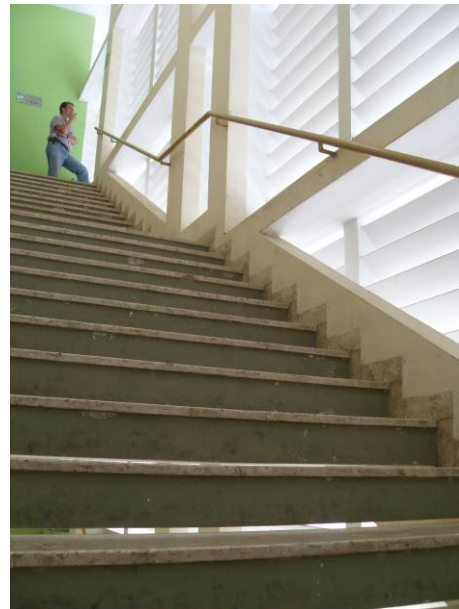
Ilustração 6 – Vãos entre os degraus da escada.
