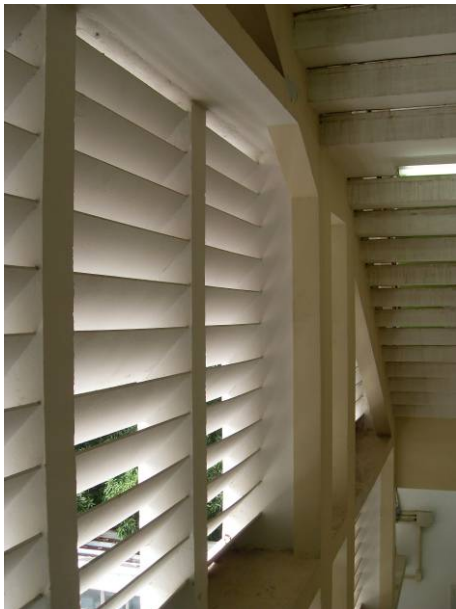
Ilustração 5 – Fechamento lateral da escadaria com brise-soleil .
