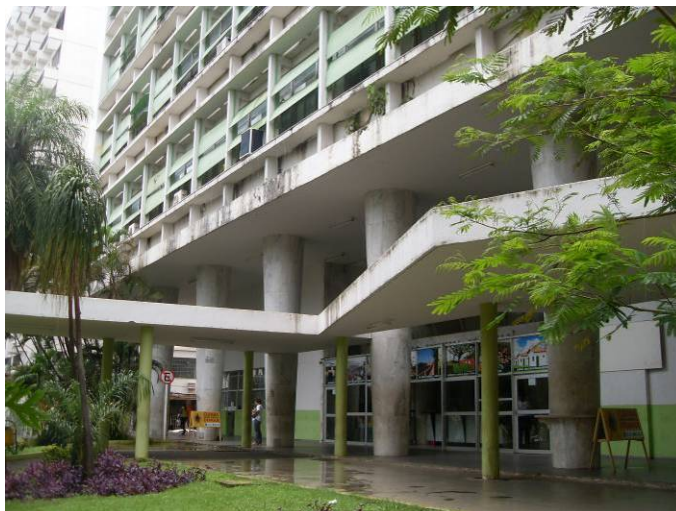
Ilustração 7 – Marquise independente e brise-soleil.
