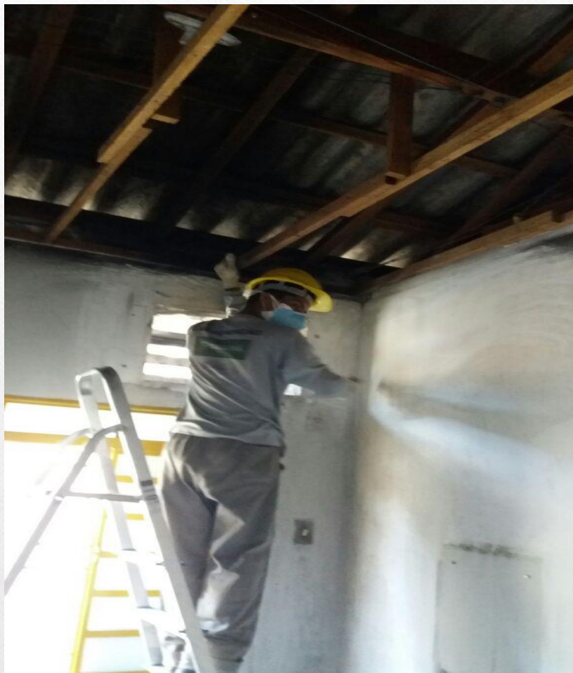
Figura 1: Substituição do forro
