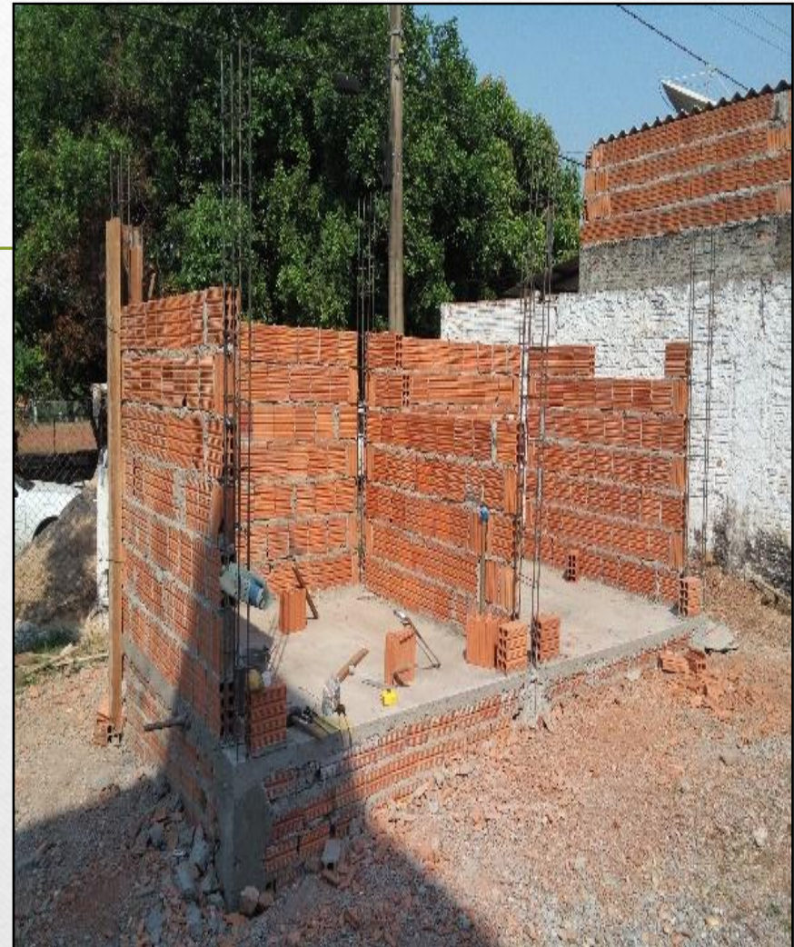
Figura 2: Levantamento da alvenaria
