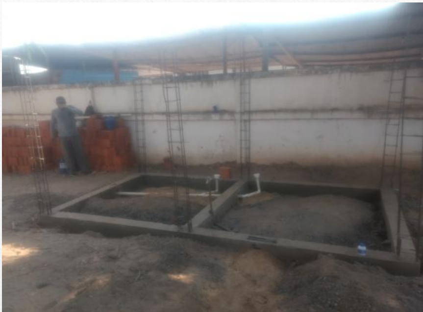
Figura 1: Finalização da viga baldrame
