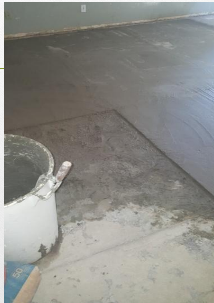
Figura 2: Execução de granilite
