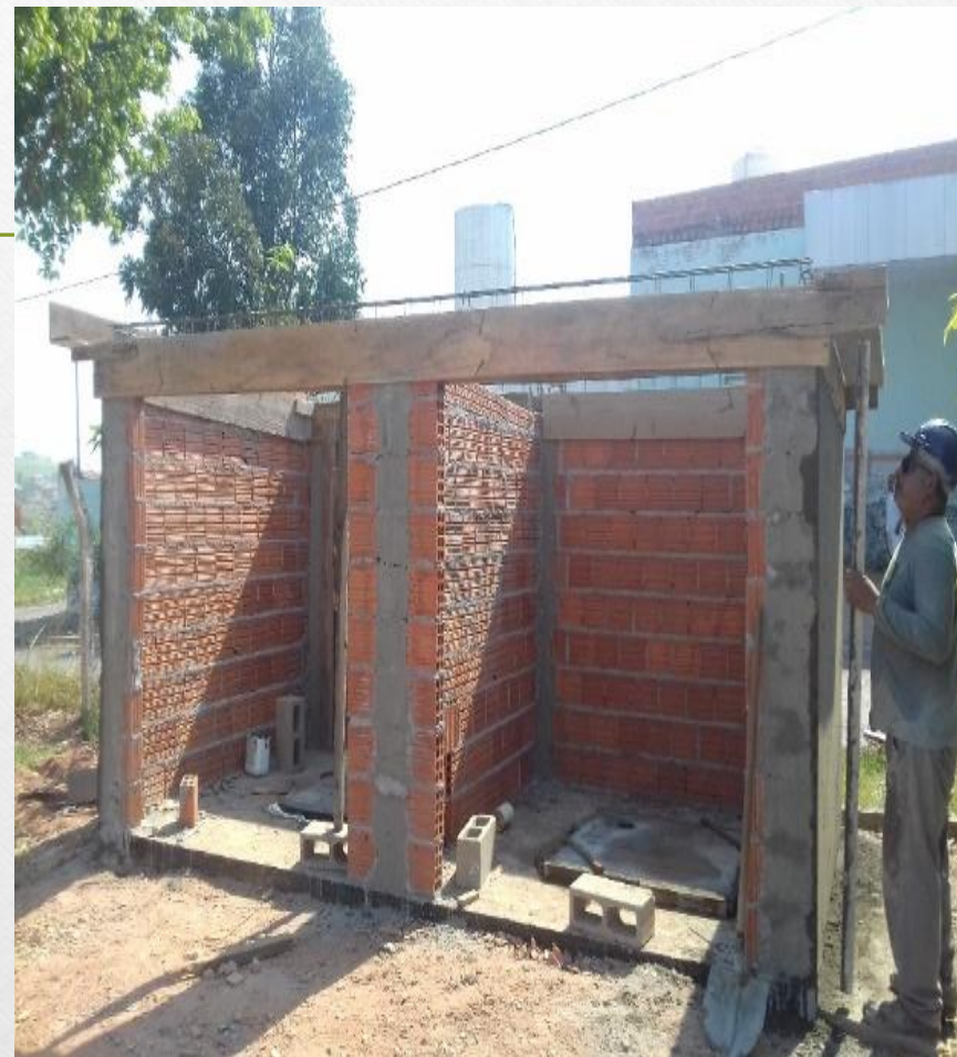
Figura 2: Levantamento da alvenaria
