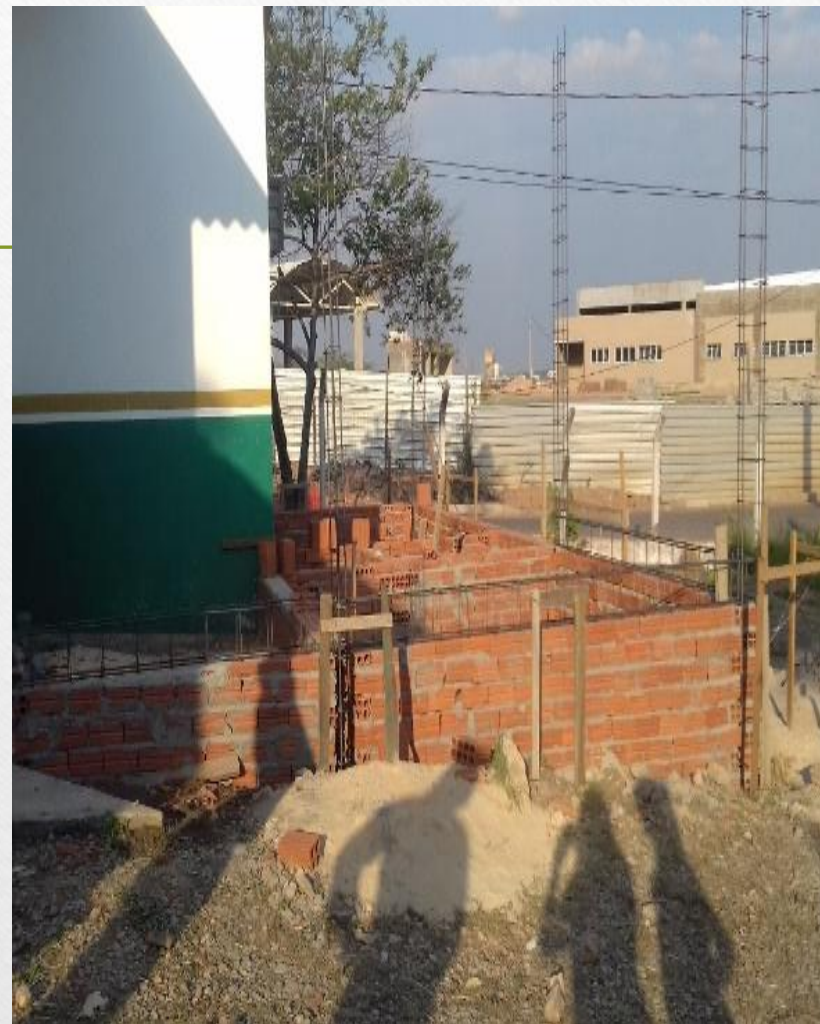
Figura 2: Levantamento de alvenaria
