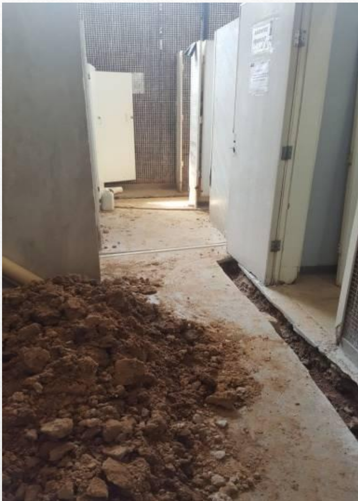
Figura 1: Revisão de tubulações de esgoto obstruídos.
