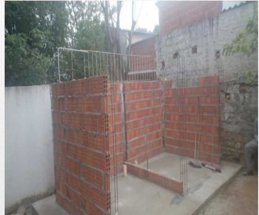
Figura 2: Levantamento alvenaria de fechamento
