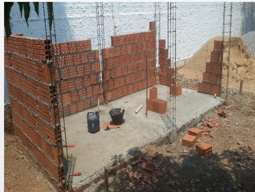
Figura 2: Levantamento alvenaria de fechamento
