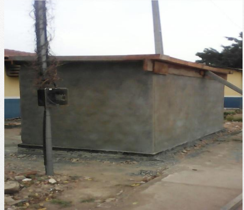
Figura 2: Levantamento alvenaria de fechamento
