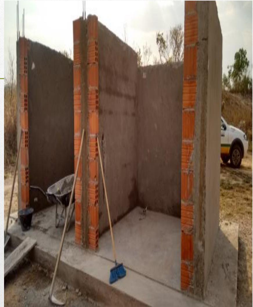
Figura 2: Levantamento da alvenaria
