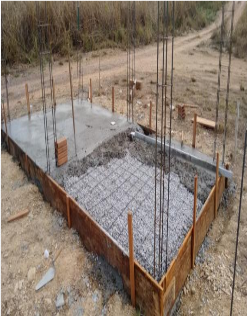
Figura 1: Construção abrigo de resíduos
