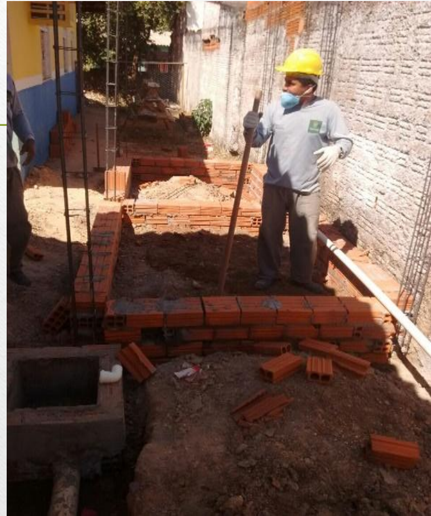
Figura 2: Construção do abrigo de resíduos
