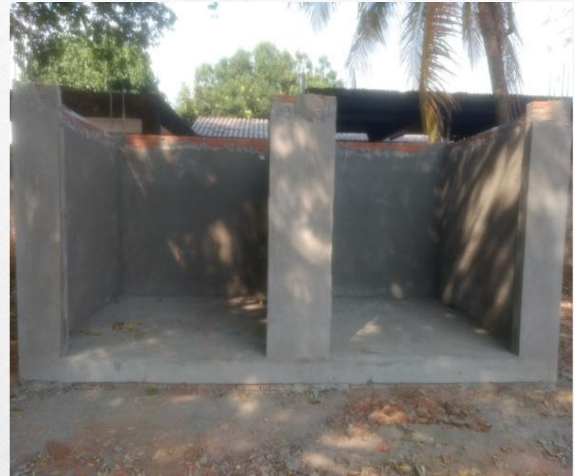
Figura 4: Término da alvenaria de fechamento
