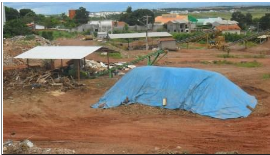
Foto 20: Estrutura da ATT – Área de Triagem e Transbordo
