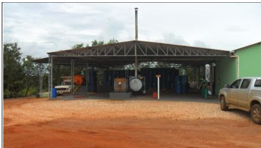
Foto 28: Galpão da empresa Máxima Ambiental e Autoclave
