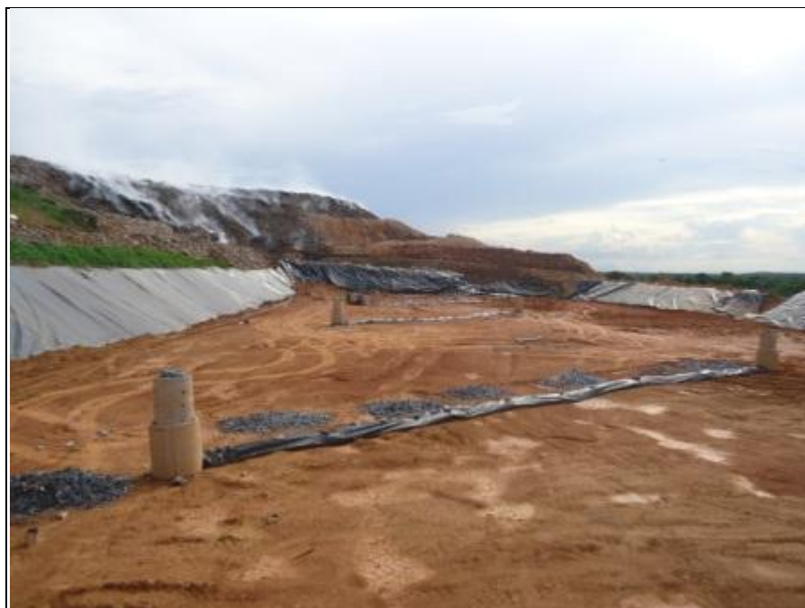
Foto 10: drenagem e impermeabilização da nova célula de resíduos – fevereiro 2013
