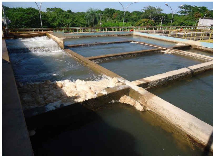
ETA TIJUCAL 03 – Floculador indicando operação acima da capacidade nominal da ETA -18.02.2016
