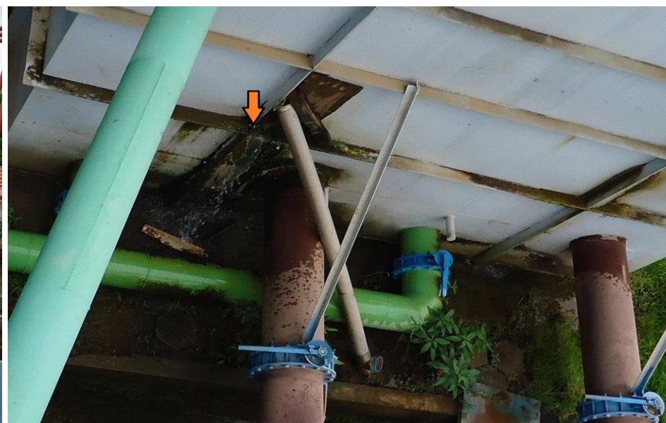
ETA Lipa – Filtro com Vazamento -09.12.2015
