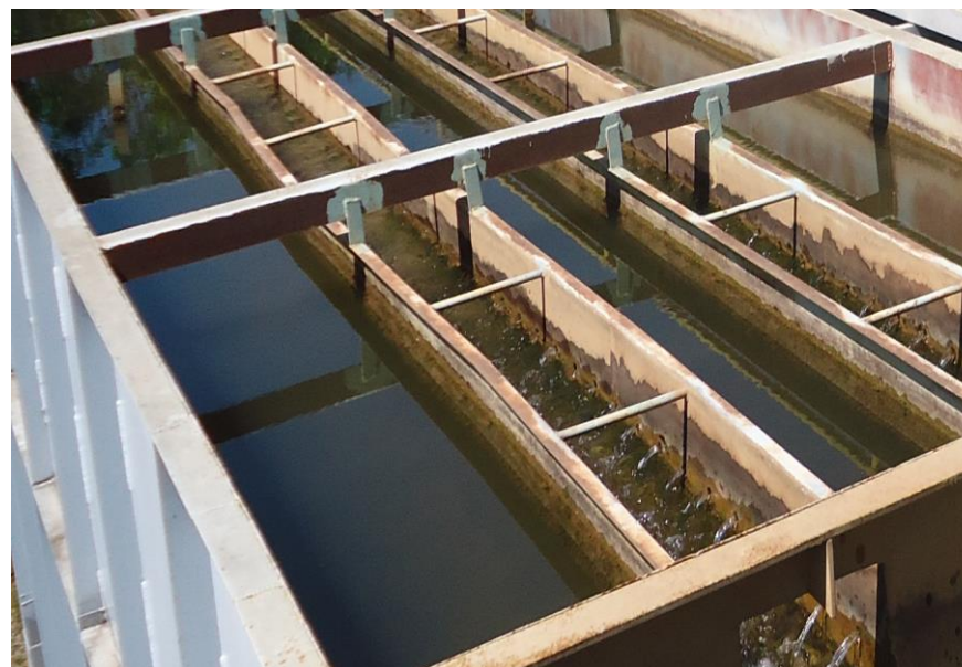
ETA TIJUCAL 02 – Decantador com aspecto de alto teor de sólidos em suspensão - 18.02.2016
