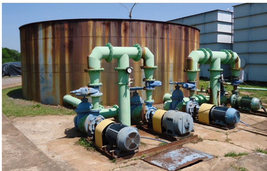
ETA CoopHEMA – Reservatório apoiado em estado avançado de deterioração – 14.12.2015
