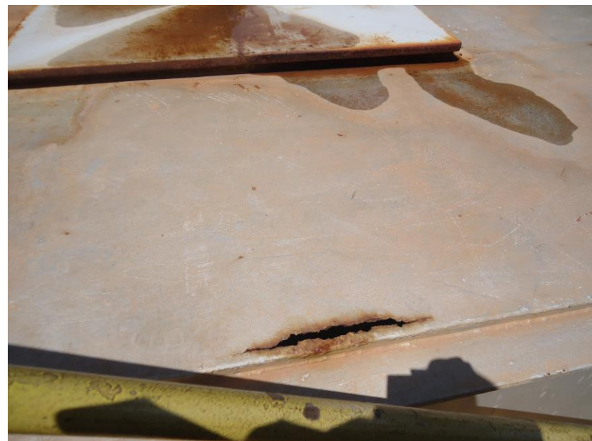
ETA Porto –Reservatório de água tratada com vários pontos com necessidade de reparo – 05.02.2016
