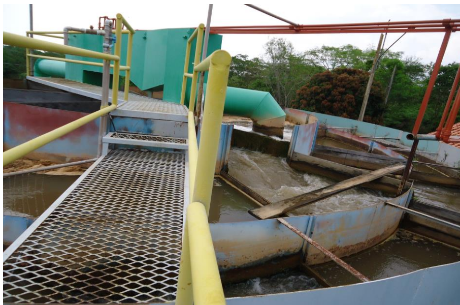
ETA Lipa – Floculador com indícios de operação acima da capacidade nominal da ETA – 09.12.2015.
