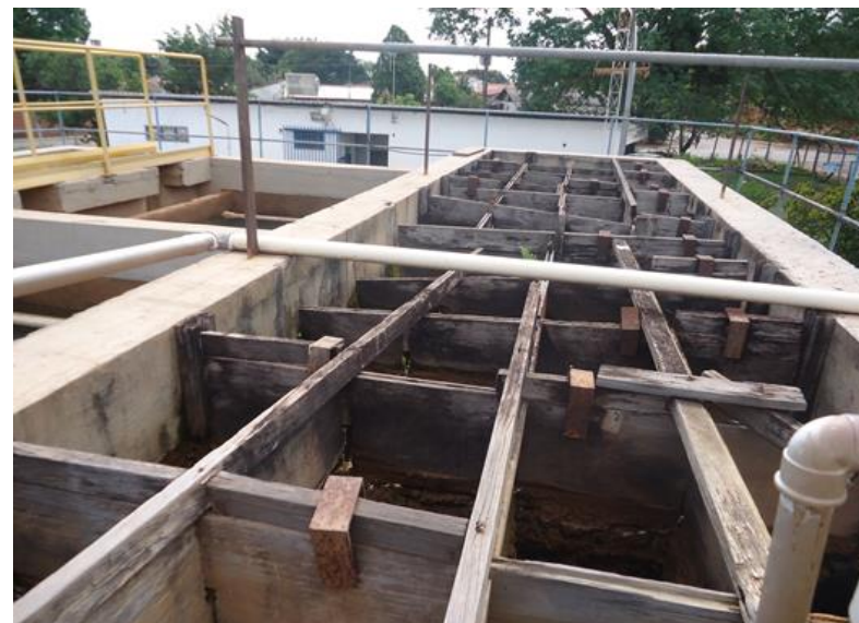
ETA Parque Cuiabá – Floculador em estado avançado de deterioração – 22.02.2016
