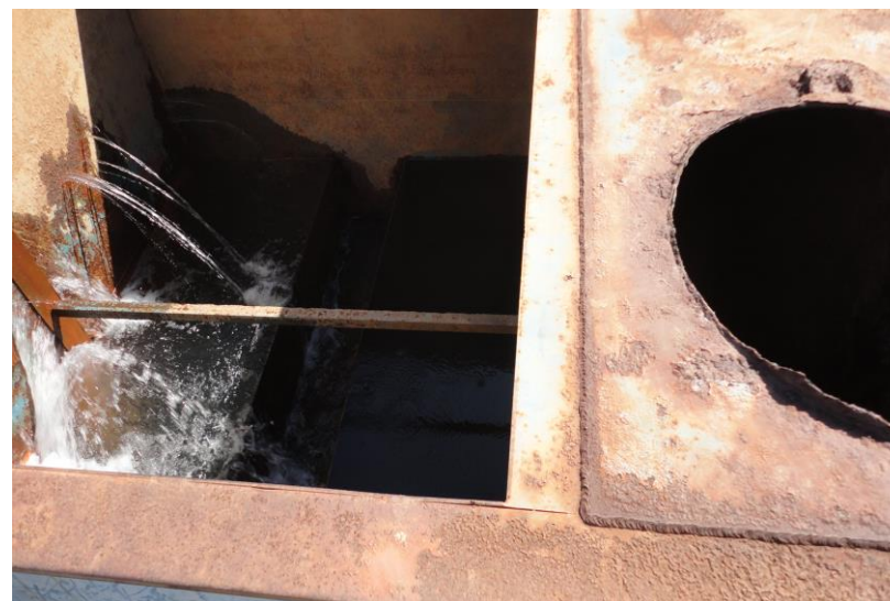
ETA CoopHEMA – Parte do Filtro e Câmara de contato – em estado de oxidação elevada - 14.12.2015
