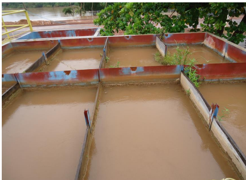
ETA Porto – Floculador em estado de má conservação e com indícios de operação acima da capacidade nominal da ETA - 28.01.2016
