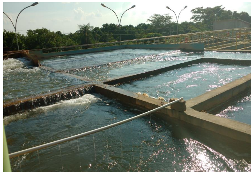
ETA Tijucal 3 – Floculador indicando operação acima da capacidade nominal da ETA -14.12.2015
