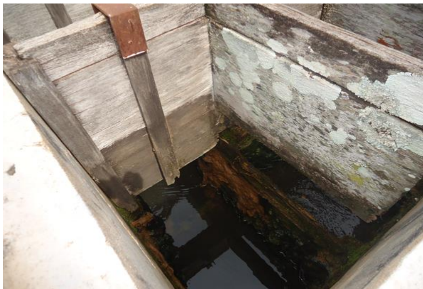
ETA Parque Cuiabá – Floculador em estado avançado de deterioração – 22.02.2016
