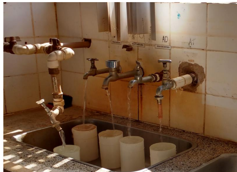
ETA Parque Cuiabá – Ponto de coleta de amostras para análise da água apresentando aspectos inadequados, podendo comprometer os resultados – 14.12.2015
