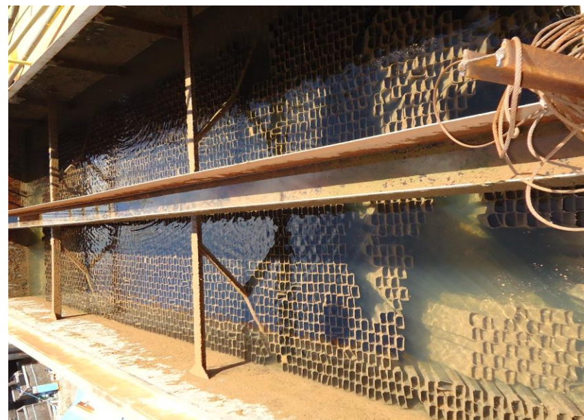
ETA Porto – Decantador apresentando deficiências nos módulos de decantação – 05.02.2016
