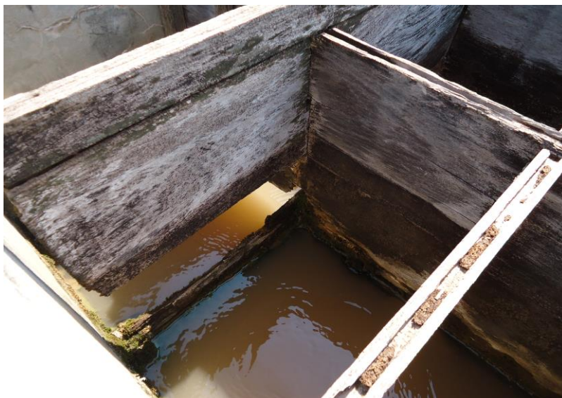
ETA Parque Cuiabá – Floculador em estado avançado de deterioração 14.12.2015
