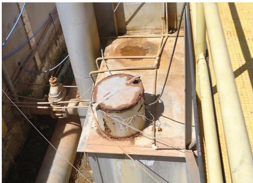
ETA Porto – Tampa de reservatório de água tratada em processo de deterioração - 05.02.2016
