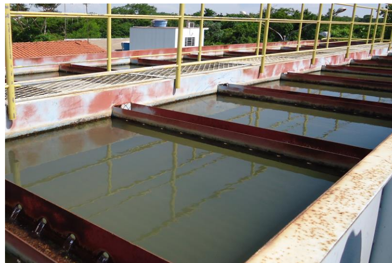
ETA CoopHEMA – Decantador com aspecto de alto teor de sólidos em suspensão - 14.12.2015
