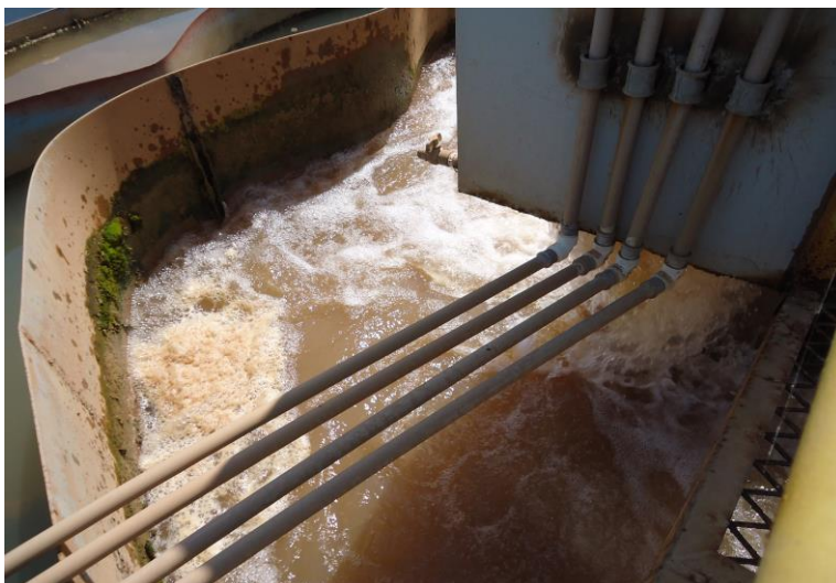
ETA CoopHEMA – Floculador em estado avançado de deterioração – 14.12.2015
