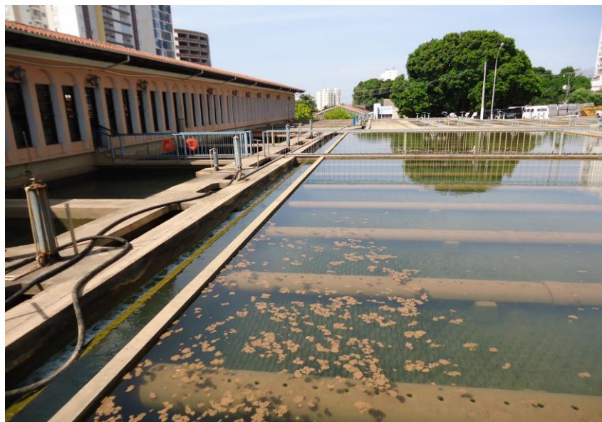
ETA São Sebastião/Central – Decantador com indícios de operação acima da capacidade nominal da ETA – 15.12.2015
